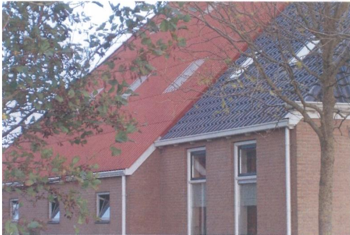
Goede detaillering aansluiting dakpannen/dakpanprofielplaat
