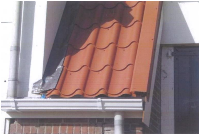
Te “rijke”goot op het schuurdeel, weinig aandacht voor zetwerk, zoveel mogelijk vermijden.
