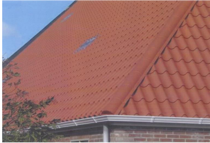
Zwakke profilering hoekkeper, matte dakpanplaat
